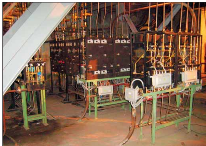
Рис. 2 Комплекс автоматизированного управления подачей газов для МГР МНЛЗ.
